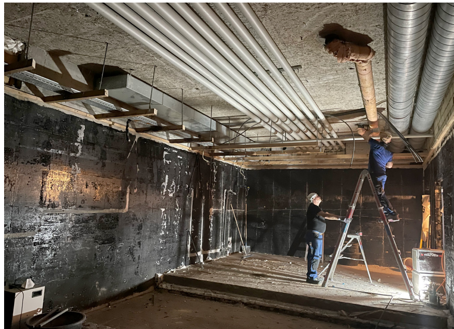
Rohbausituation nach Rückbau von Kühl-, Tiefkühl-, Gemüse Kühl- und Getränkekühlraum
