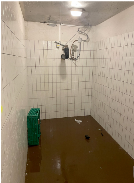
Kühlraum alt vor dem Rückbau
